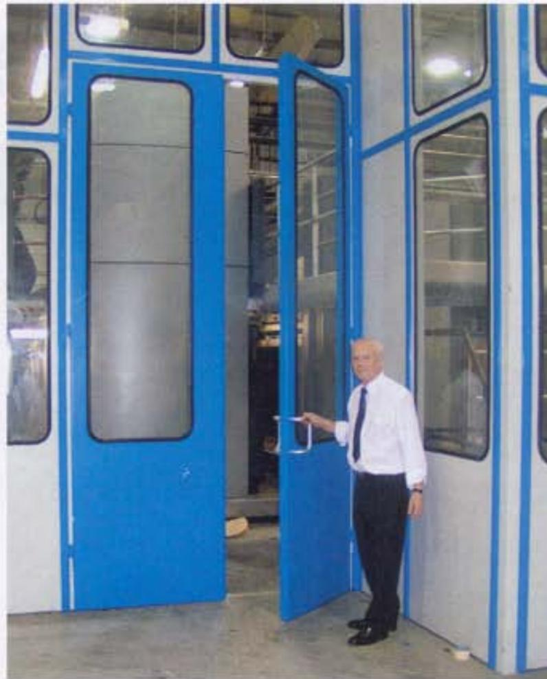
**Nachträglich eingebaute Spezialtür mit 3,5 Metern lichter Höhe.**
