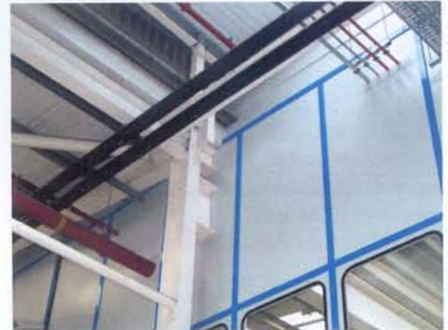
**Detailansicht des schalldichten Dachanschlusses.**
