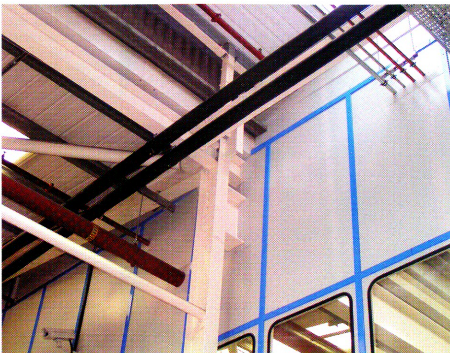
Detailansicht des schalldichten Dachanschlusses. (Foto: NOISE-EX-INTERNATIONAL)
