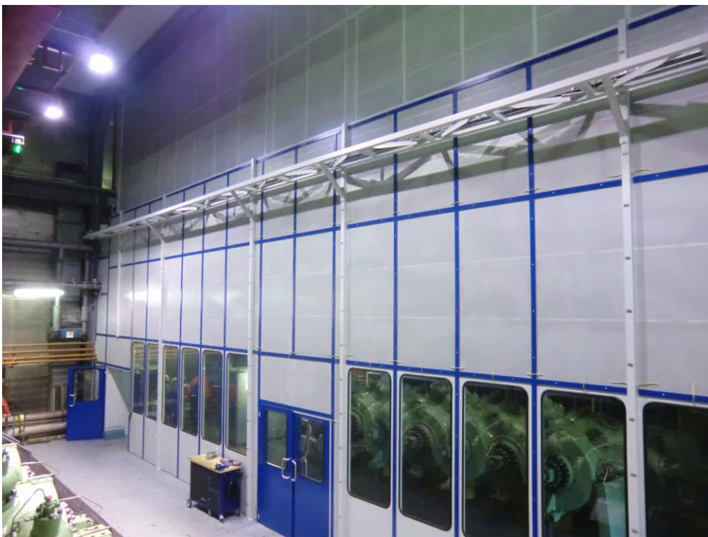
Trennwand in hochfahrenem Zustand. Kompletter Schallschutz und mechanischer Schutz.
